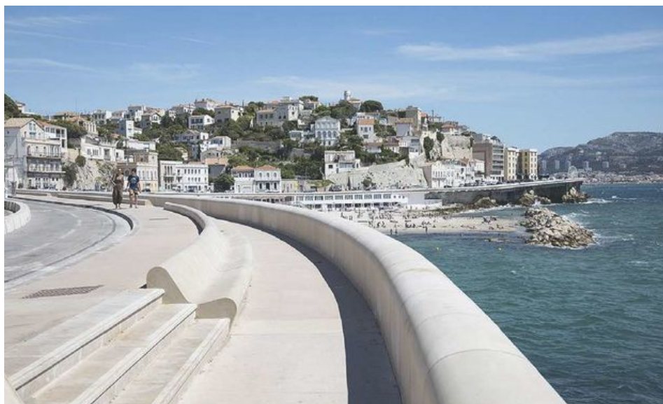
André Mascarelli, Corniche Kennedy. Banc de 3km à Marseille, fondu dans la promenade. Exemple typique d'affordance en urbanisme : la surface, la hauteur, la position du bloc de béton induit une utilisation instinctive : en l'occurrence, celle de s'asseoir.
